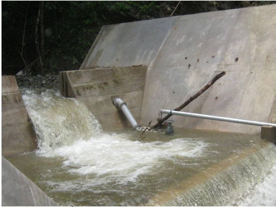
ฝายบ้านน้ำไคร้ ขนาดสันฝายสูง 2.5 เมตร ยาว 6 เมตร
