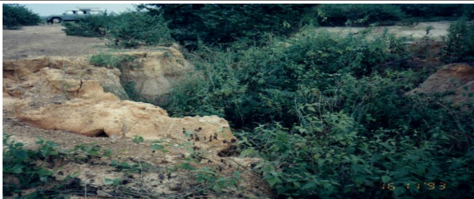
สภาพการพังทลายแบบร่องลึก (Gully erosion)
