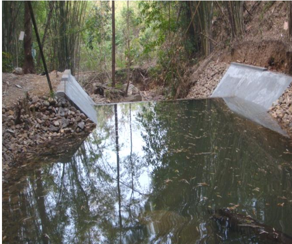
ก่อสร้างบ่อเก็บน้ำคอนกรีตเสริมเหล็กขนาดความจุ 200 ลูกบาศก์เมตร
