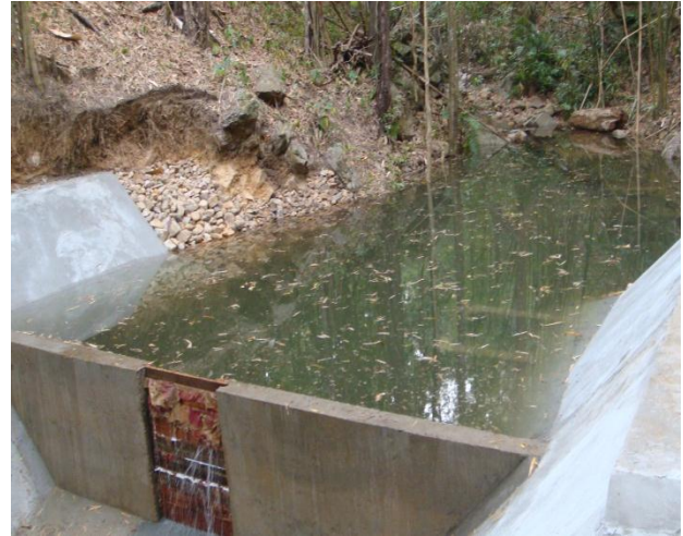
ก่อสร้างบ่อเก็บน้ำคอนกรีตเสริมเหล็กขนาดความจุ 200 ลูกบาศก์เมตร
