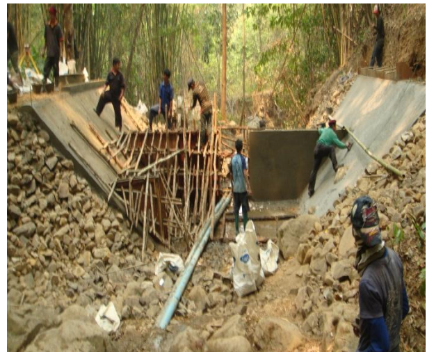
ดำเนินการก่อสร้างอาคารบังคับน้ำ จำนวน 1 แห่ง พร้อมระบบส่งน้ำ
