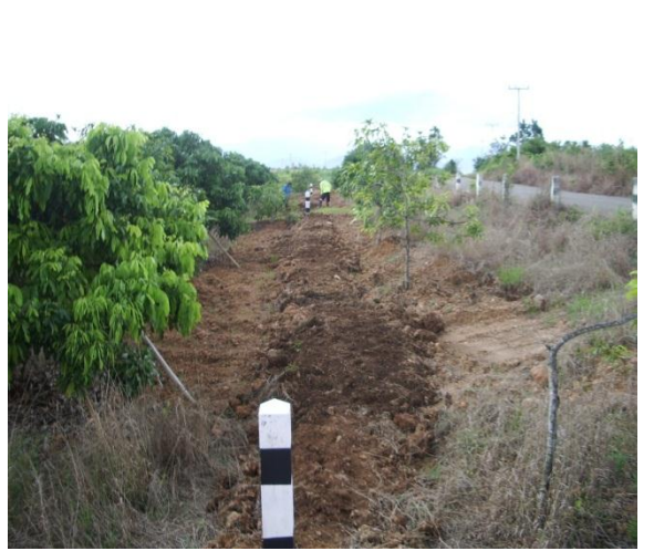
งานดินขุดเพื่อวางแนวท่อส่งน้ำ
