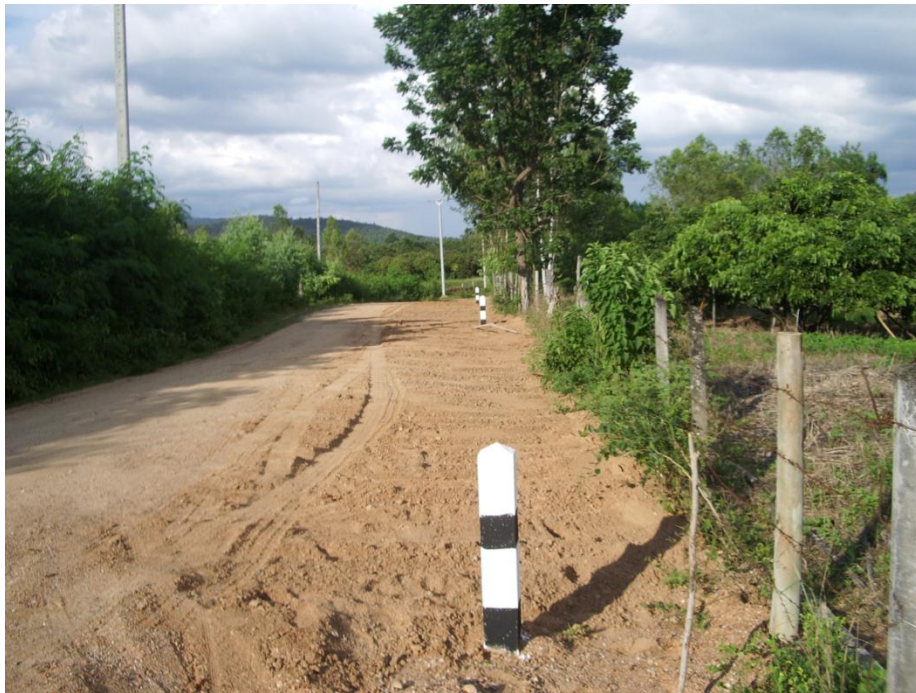
แนวงานวางระบบท่อส่งน้ำ
