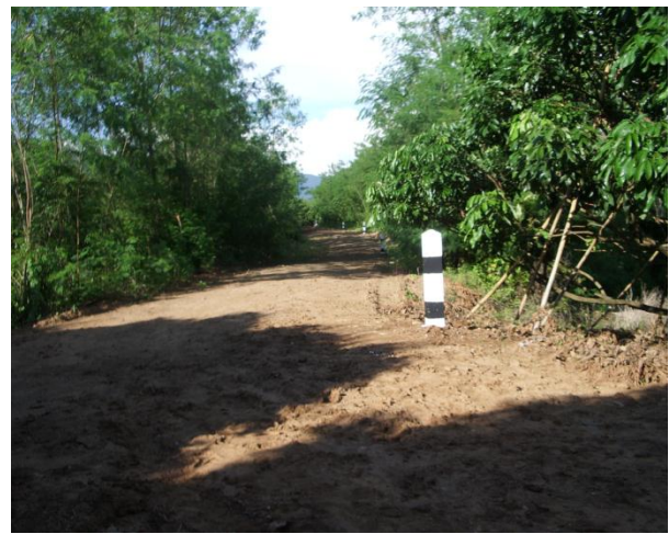
แนวงานวางระบบท่อส่งน้ำ
