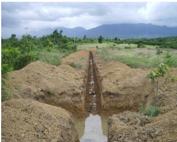
งานดินขุดเพื่อวางแนวท่อส่งน้ำ
