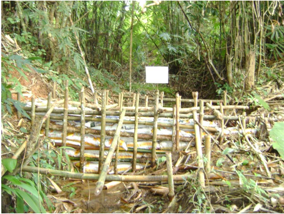
การก่อสร้างฝายต้นน้ำแบบผสมผสาน
