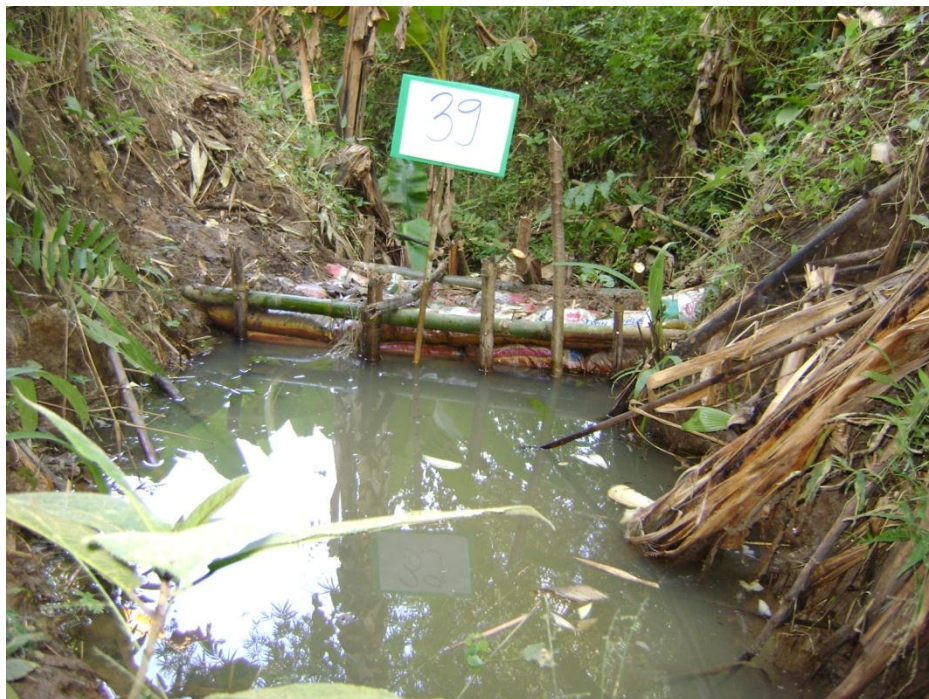
การก่อสร้างฝายต้นน้ำแบบผสมผสาน
