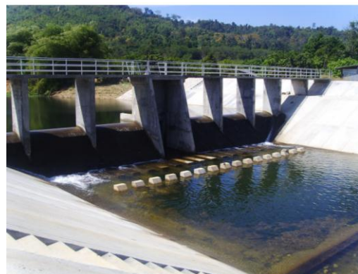
ดำเนินการก่อสร้างฝายน้ำล้นพร้อมอาคารประกอบ
