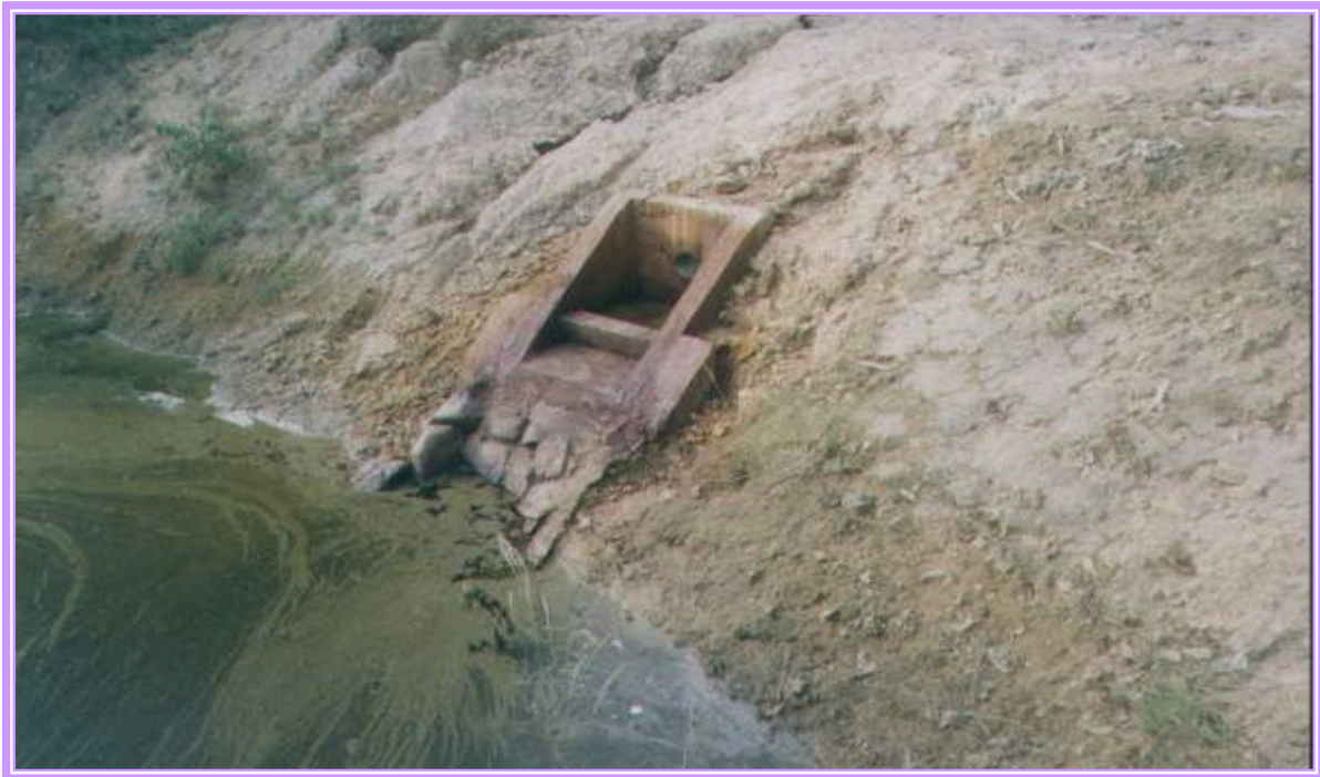
อาคารปลายท่อส่งน้ำก่อนลงสระเก็บน้ำเดิม
