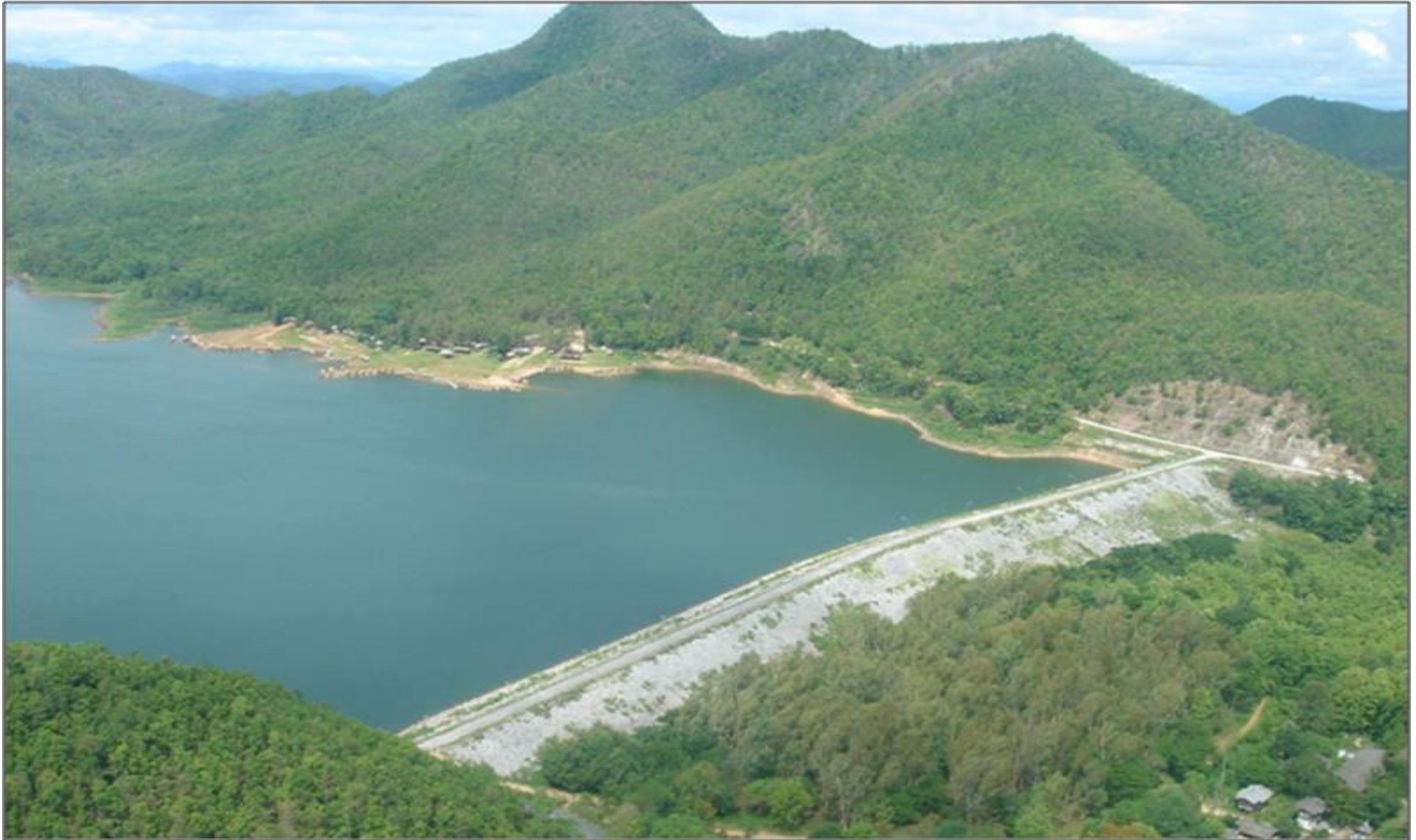
อ่างเก็บน้ำแม่ตีบ ตำบลมะเขือแจ้ อำเภอเมือง จังหวัดลำพูน
